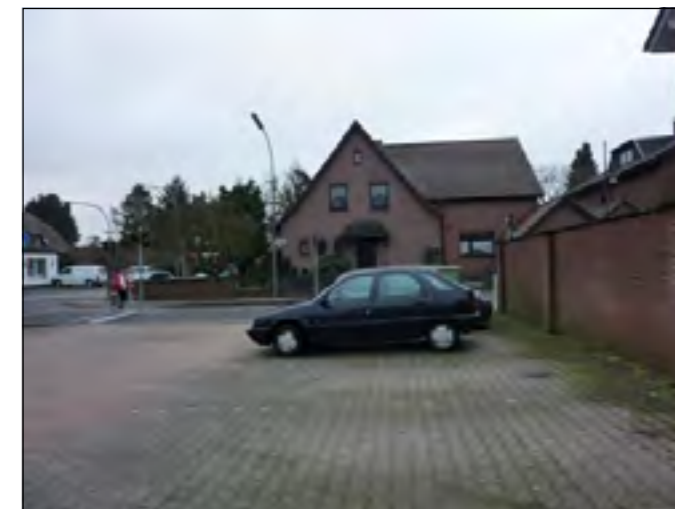
Eine Begrünung der Einfriedungsmauer täte der Optik und dem Mikroklima gut.
