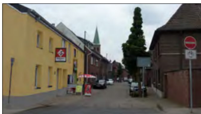
Leicht besser ist eine ockergelbe Fassade über dunkelgrauem Sockel.
